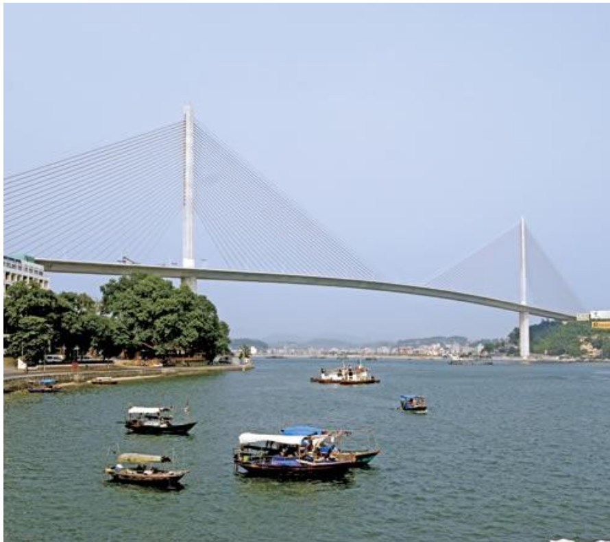
図3 BOTDR 光ファイバセンサーを設置した吊り橋 (ベトナム, バイチャイ橋)
