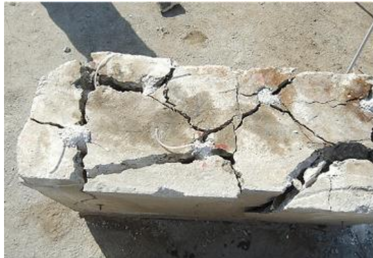
「静的破碎剤 ロックトーン」によるコンクリート破碎状況
