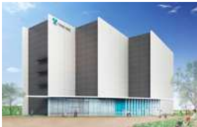
エネルギーセンター竣工
