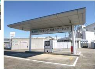
水素ステーション整備
