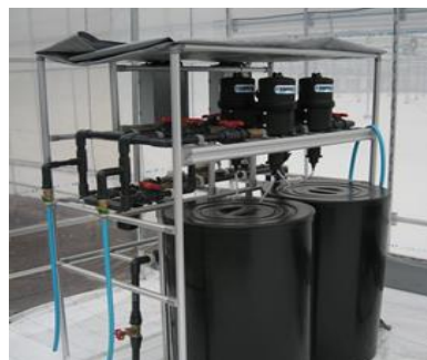
給液装置等を設置
