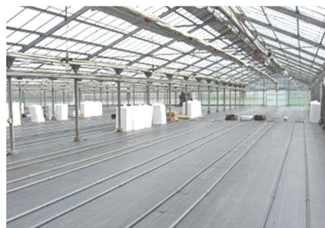
ベッド枠（パイプ）を設置
