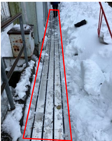
図3 融雪パネル付設状態 電気器具箱の前面に融雪 パネルを敷設して通路と 開閉部を確保する。
